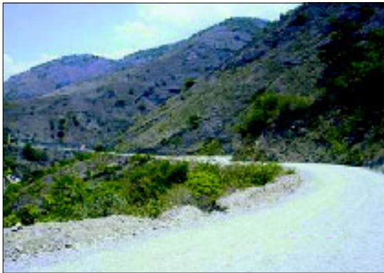
Mantenimiento de infraestructura vial no pavimentada
